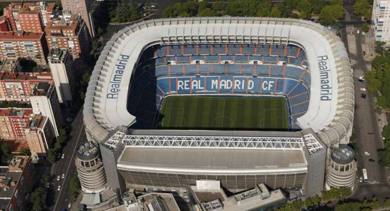
Vista aérea del estadio Santiago Bernabéu.
